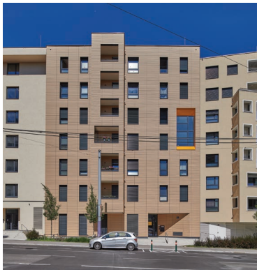
In Wien, Österreich geben Albert Wimmer ZT Architekten dem Wohnquartier mit KeraTwin eine langlebige Zukunft und der Fassade ein harmonisches Gesicht. // Foto: agrob-buchtal.de / Peters Fotodesign
